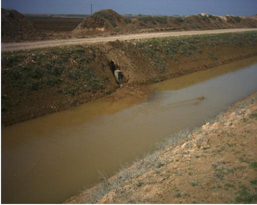
Şekil 14.17 Emici ve toplayıcı çıkış yapıları
