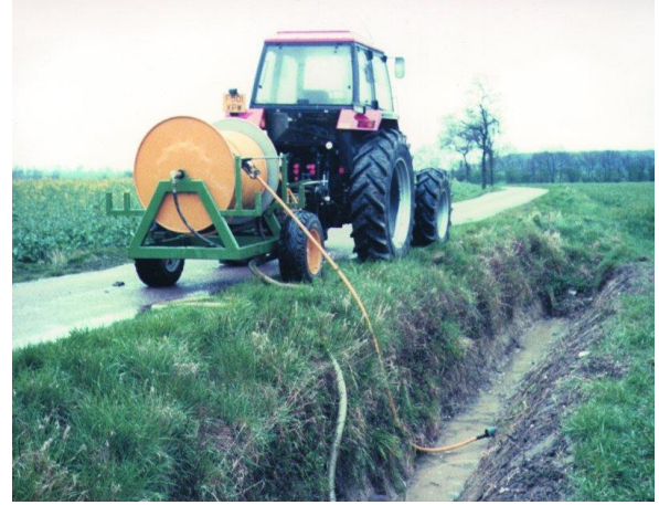
Şekil 15.1 Basınçlı su püskürtme aparatının şematik görünümü ve arazide çalışması
