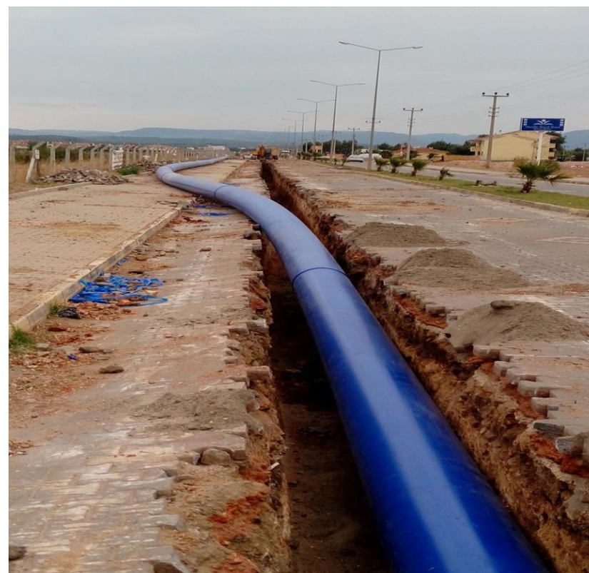
Şekil 7. Şebeke Hattı Borulaması
