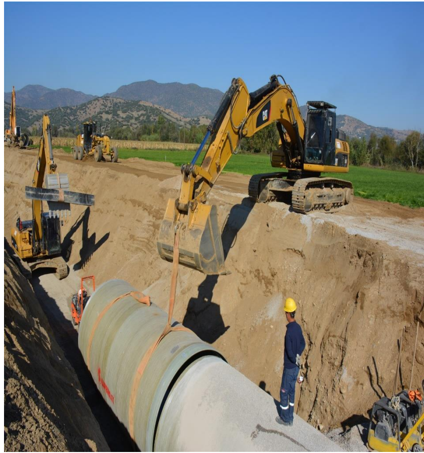
Şekil 6. İsale Hattı ve Borulaması
