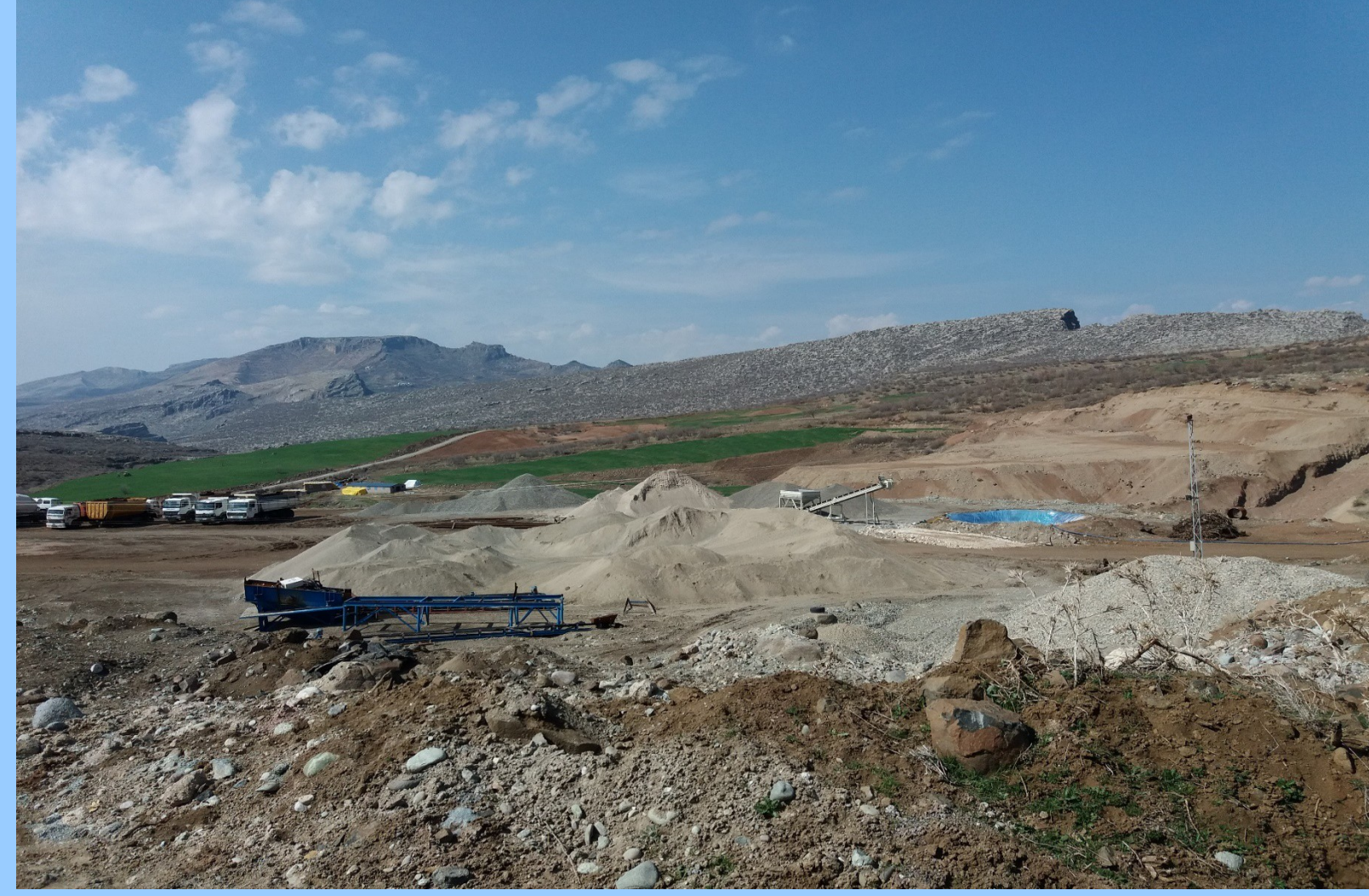
Bölgemizde yapımı tamamlanmak üzere olan Şanlıurfa-Siverek Taşıkara göleti yapılıken oluşan hafriyat ve malzemenin ötürü partiküller nedeniyle hava kalitesinde olumsuz etkisi ÇED raporunda dikkate alınması gerekir
