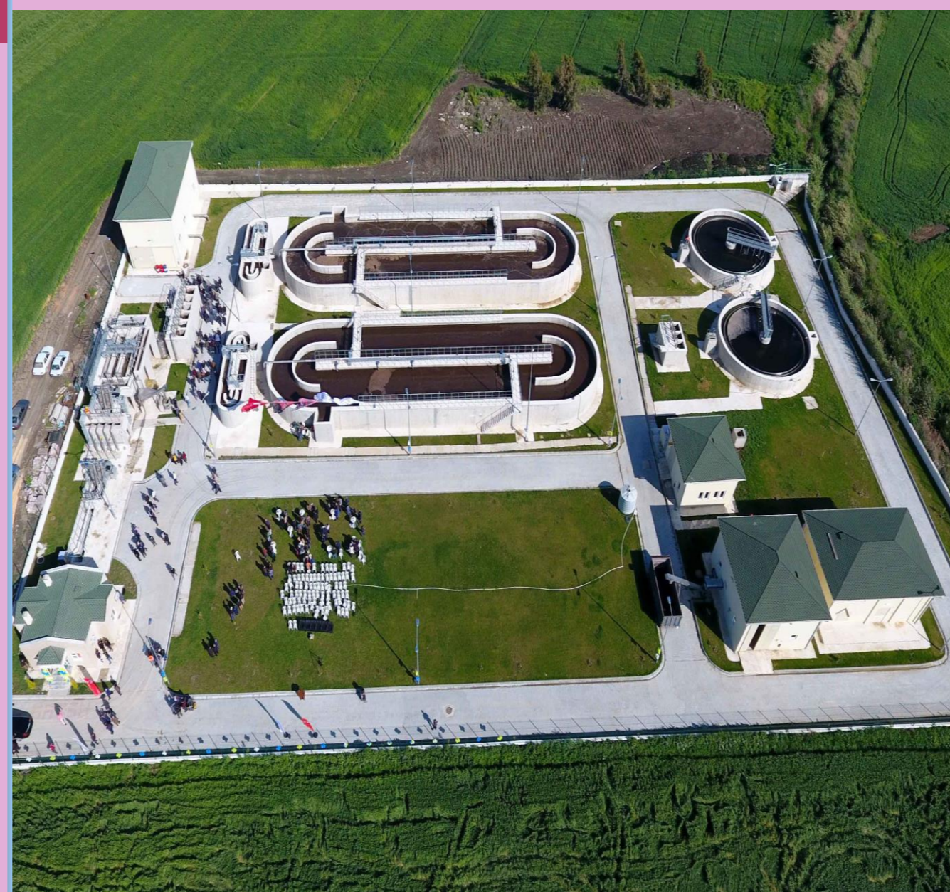
ŞEKİL 3 : Evsel atık su arıtma tesisi genel görünümü.
