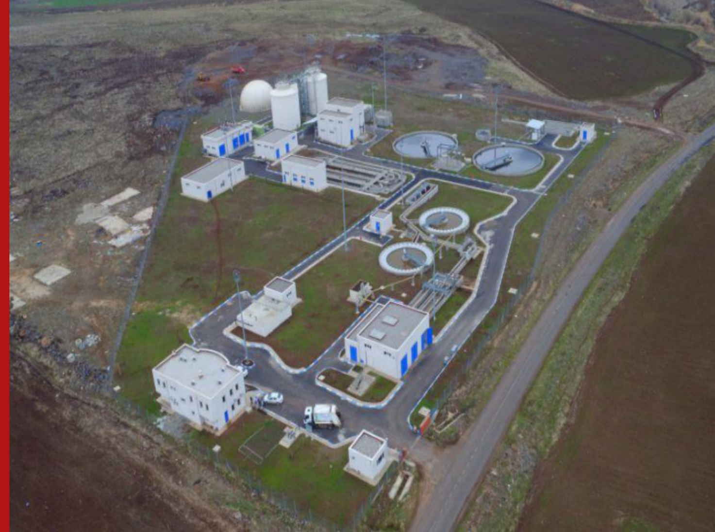
Şekil 1. Siverek Atık Su Tesisi
