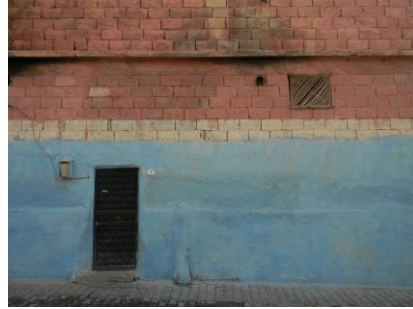
Şekil 2. Eyyübiye bölgesinde bulunan bir ev
